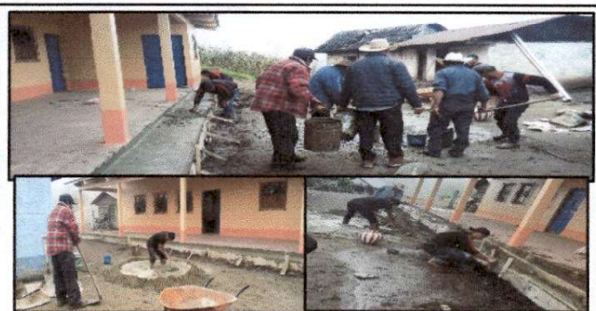
Foto 5: Reparación de banquetas de concreto
