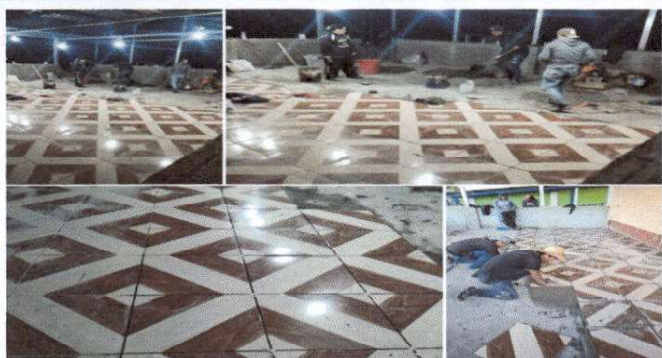
Foto1: Sustitucion de piso cerámico
