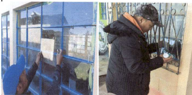
Foto 4: Sustitución de vidrios
