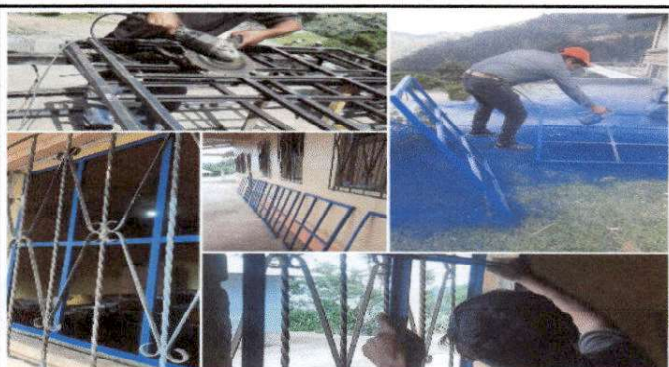
Foto 3: Sustitucion de ventana de madera por metal
